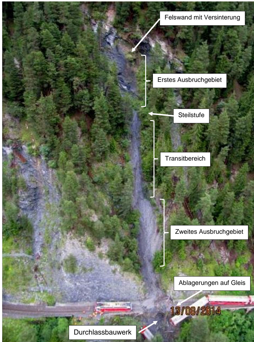
Abbildung 9: Abrutschgebiet und Unfallstelle (Quelle: CSD Ingenieure AG)
